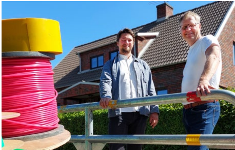
Det kommunala bolaget VaraNet bygger ut fibernätverket i Vedum och Kvänum. Björn Ekendahl Haugland är tillförordnad vd och Lars Gezelius är ordförande i bolaget.
