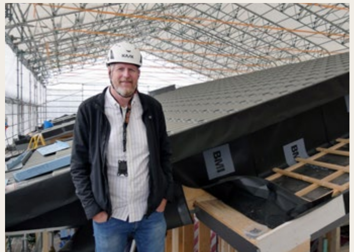
Håkan Lindell, vd Vara Bostäder, besöker byggarbetsplatsen.
